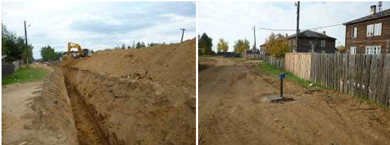
**Рисунок 2 – Процесс производства работ по текущему ремонту и устройству водопровода с установкой двух водоразборных колонок в 2014 г. на территории р.п. Новобирюсинский**
